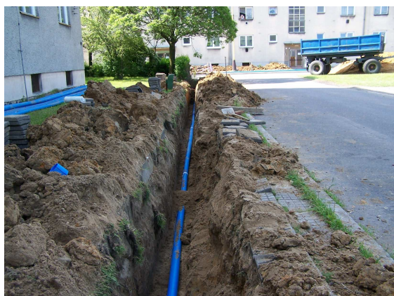
Výměna vodovodu ul. Severní
