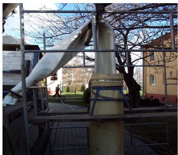
Vložkování kanalizace ul. Jarní
