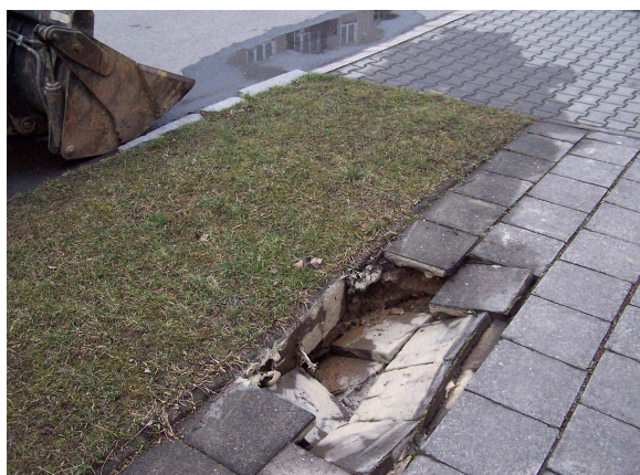
Oprava havárie na ul. Hornická I.
