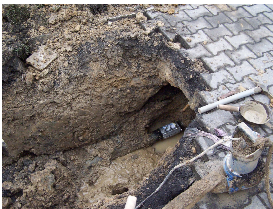
Oprava havárie na ul Hornická II.
