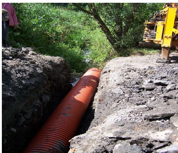
Oprava propustku ul Celní
